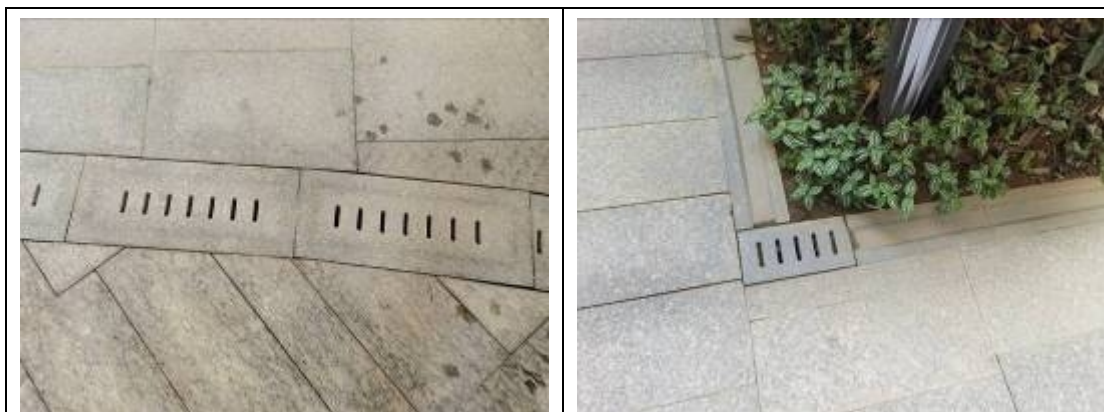
图 3.5-1 工程措施现状
