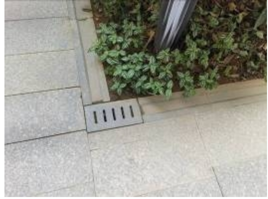
雨水排水沟及雨水收集井
