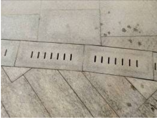
雨水排水沟及雨水收集井
