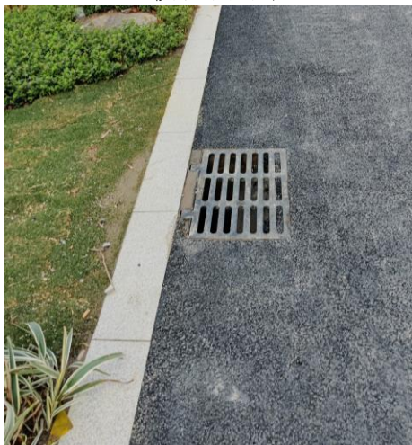
排水设施现状1
