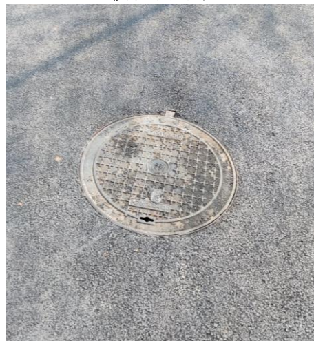
排水设施现状2
