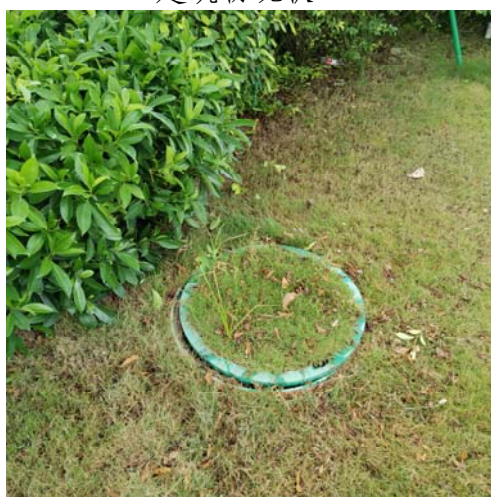
排水管网现状
