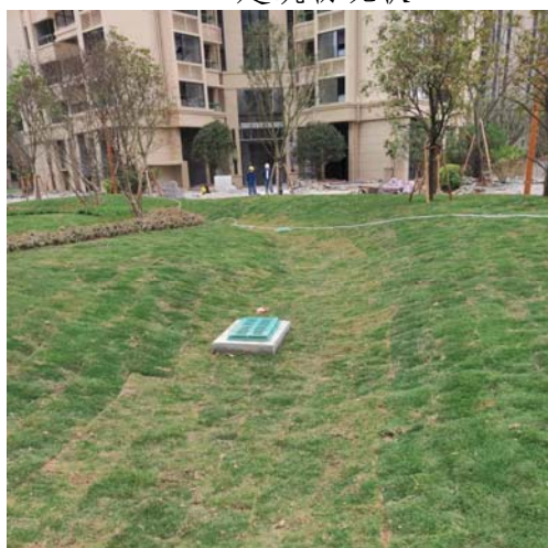
排水管网现状
