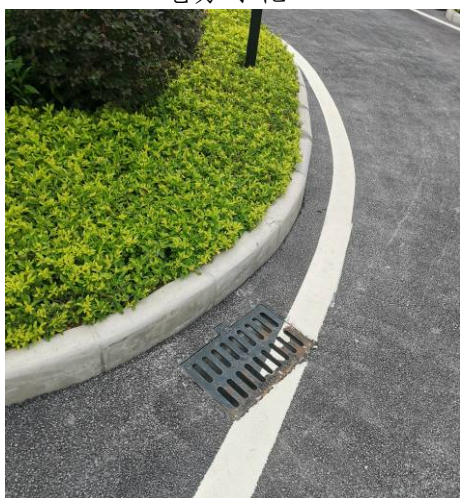
排水设施现状1
