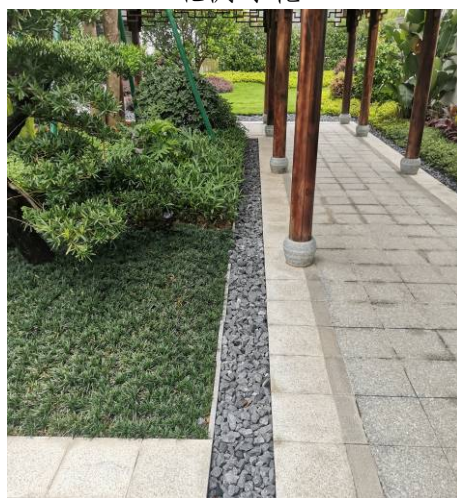
排水设施现状2
