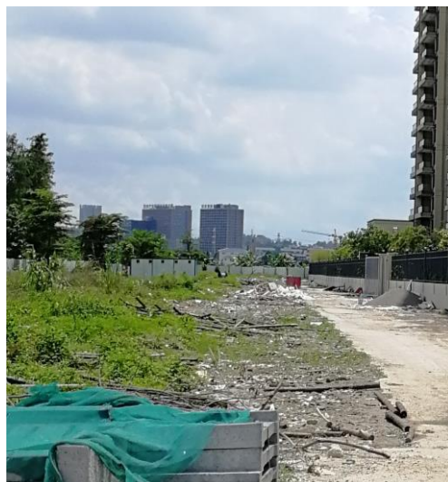
施工道路区现状2
