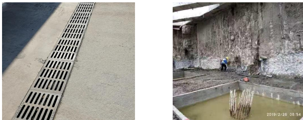
图4.3-1 水土保持临时措施
