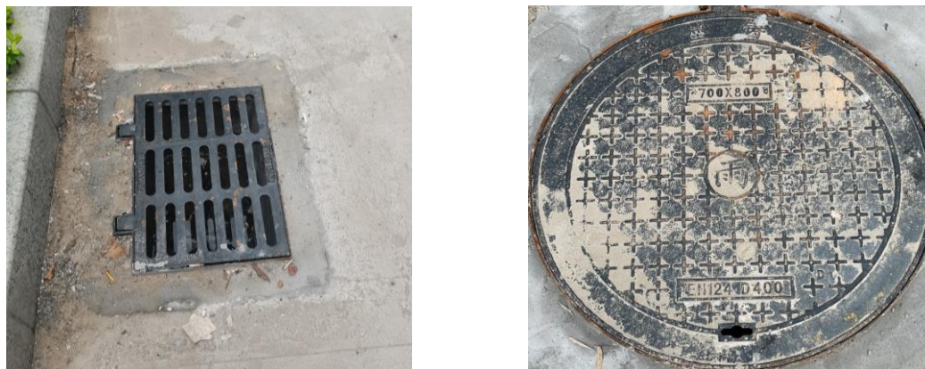
图4.1-1 水土保持工程措施现状
