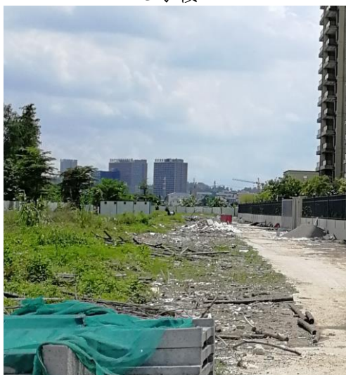
施工道路区现状2
