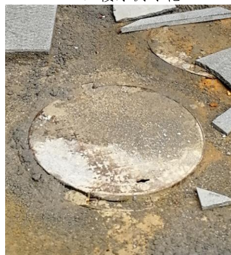
排水设施现状2
