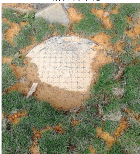
排水设施现状1
