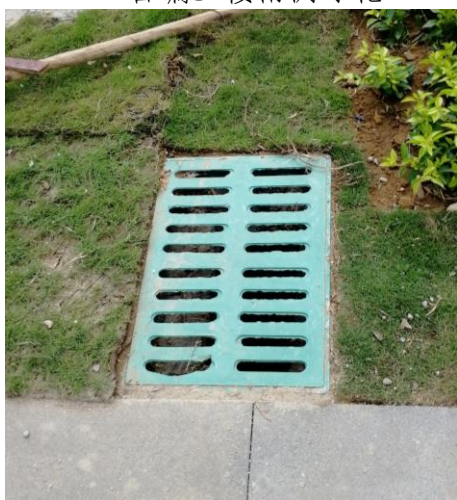
排水设施现状1
