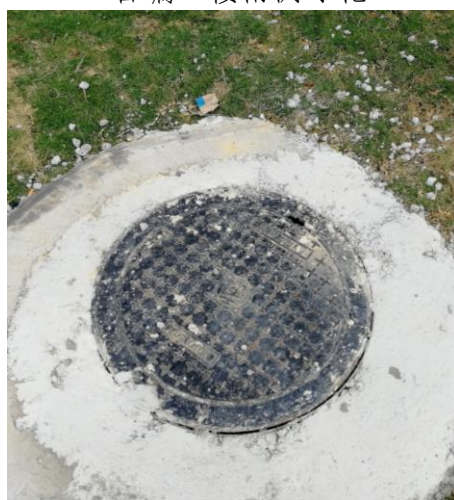
排水设施现状2
