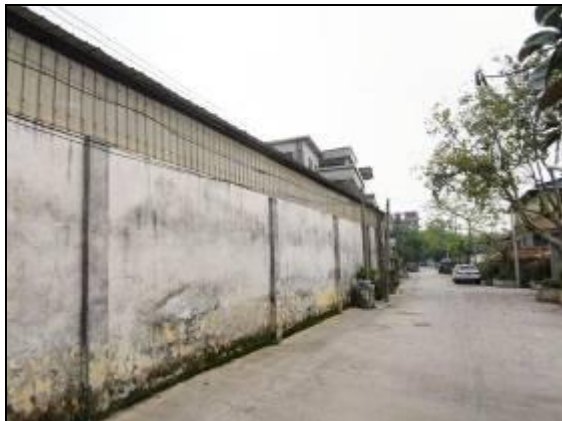
厂区北面：机械加工、喷漆、装配厂房
