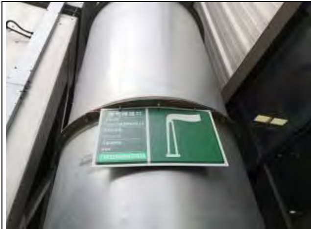
FQ-18102-61 颗粒物排放口 (近)
