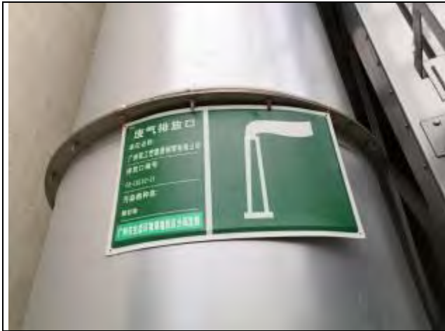
FQ-18102-37 颗粒物排放口（近）
