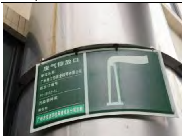
FQ-18102-51 颗粒物排放口（近）
