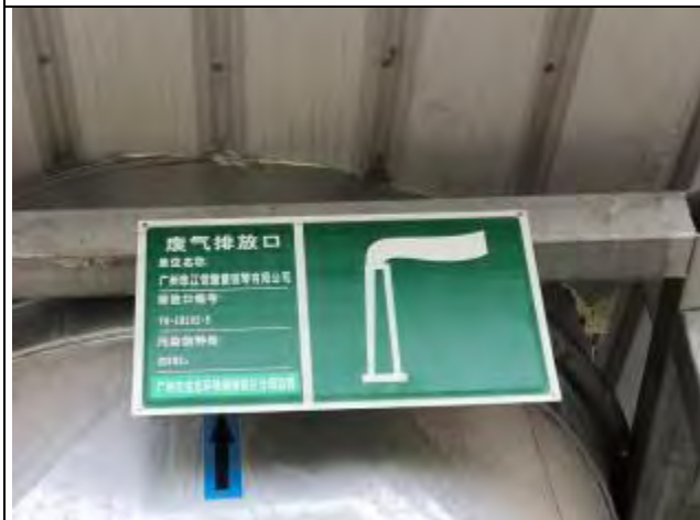
FQ-18102-5 总 VOCs 排放口（近）
