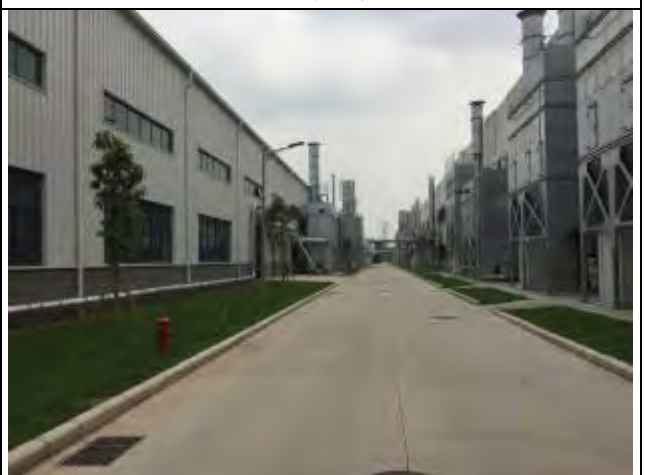
废气处理设施
