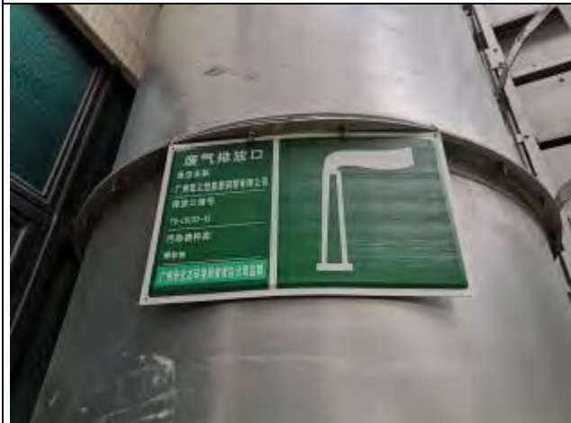
FQ-18102-45 颗粒物排放口（近）
