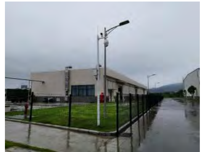
项目内化学品暂存仓
