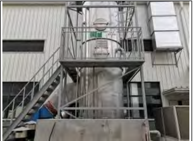
FQ-18102-25 总 VOCs 排放口 (远)
