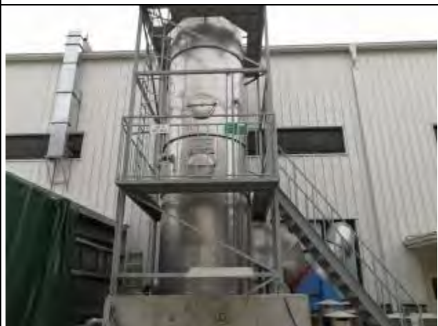
FQ-18102-23 总 VOCs 排放口 (远)
