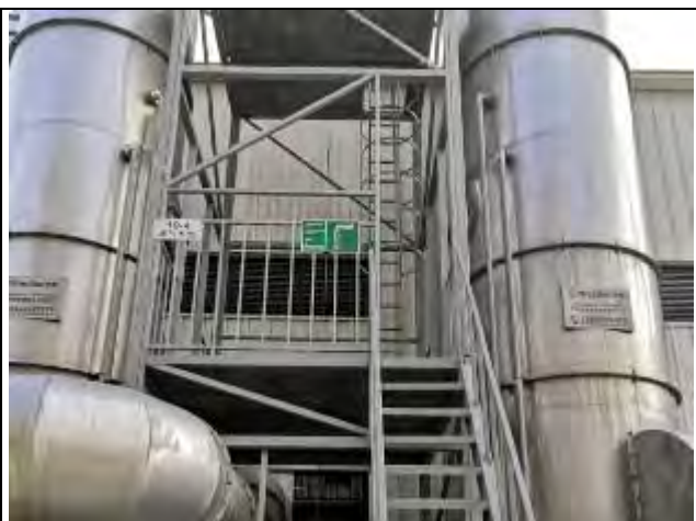
FQ-18102-22 总 VOCs 排放口 (远)
