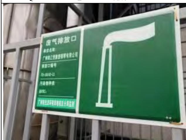
FQ-18102-11 总 VOCs 排放口 (近)
