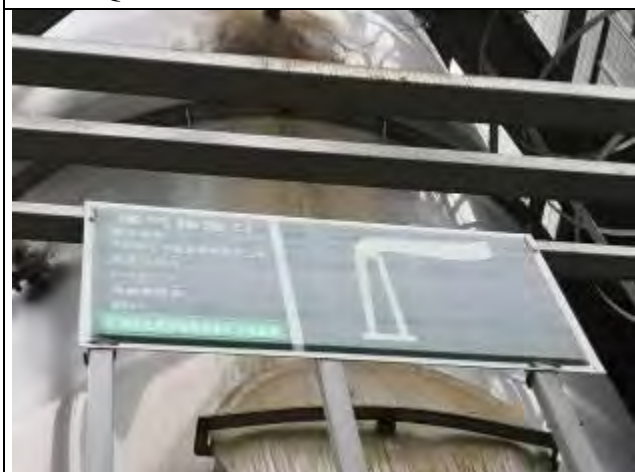
FQ-18102-8 总 VOCs 排放口 (近)
