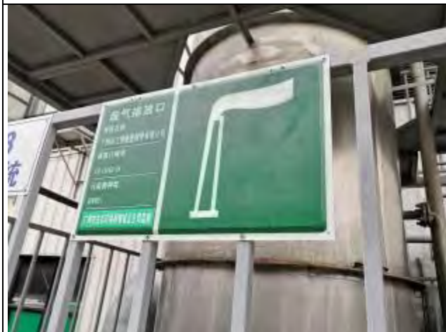
FQ-18102-26 总 VOCs 排放口 (近)
