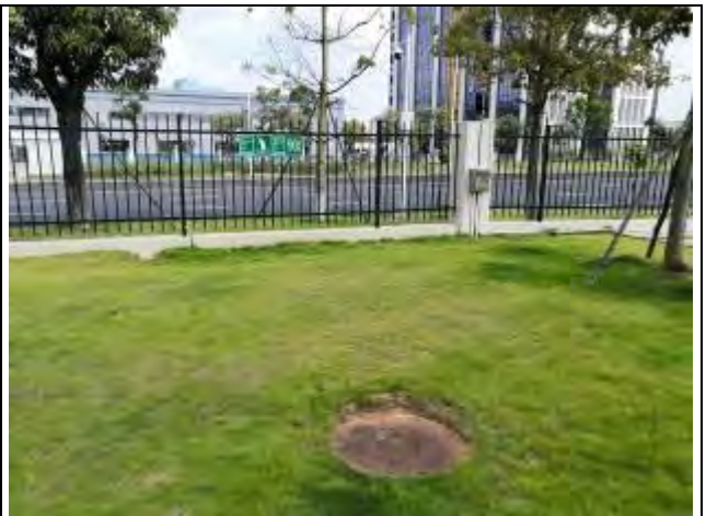
WS-18102-2 生活污水排放口（远）
