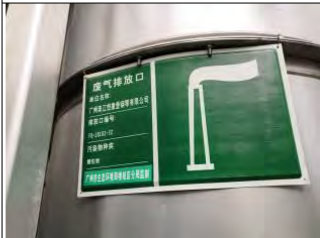
FQ-18102-32 颗粒物排放口 (近)
