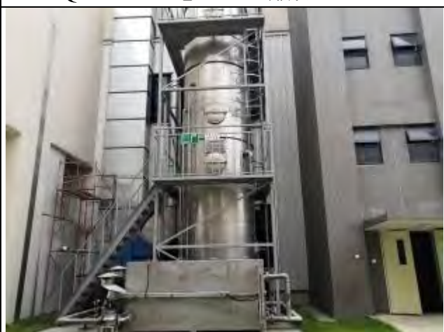
FQ-18102-12 总 VOCs 排放口 (远)
