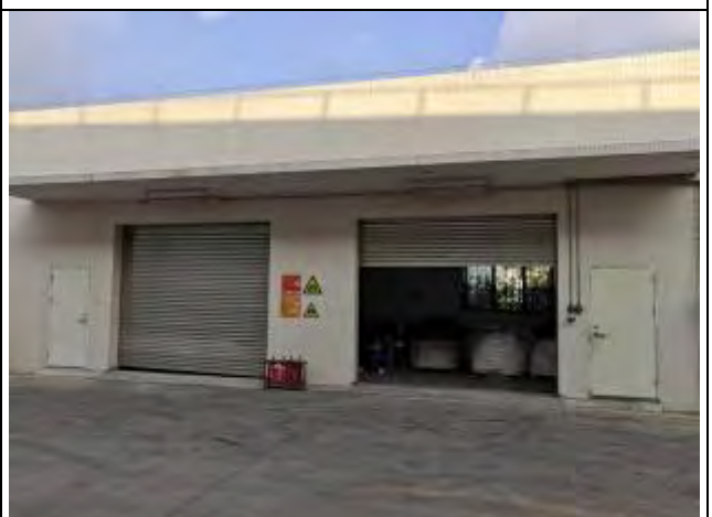
GF-18102-2 危险废物暂存间（远）
