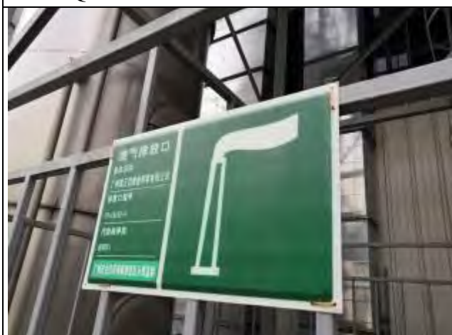
FQ-18102-9 总 VOCs 排放口 (近)
