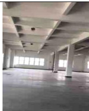
项目现状照片
