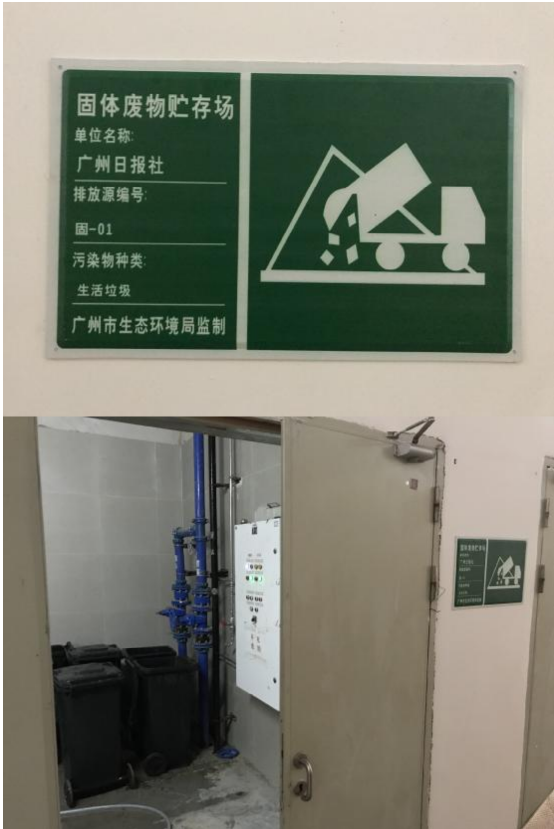
固-01 生活垃圾储存间
