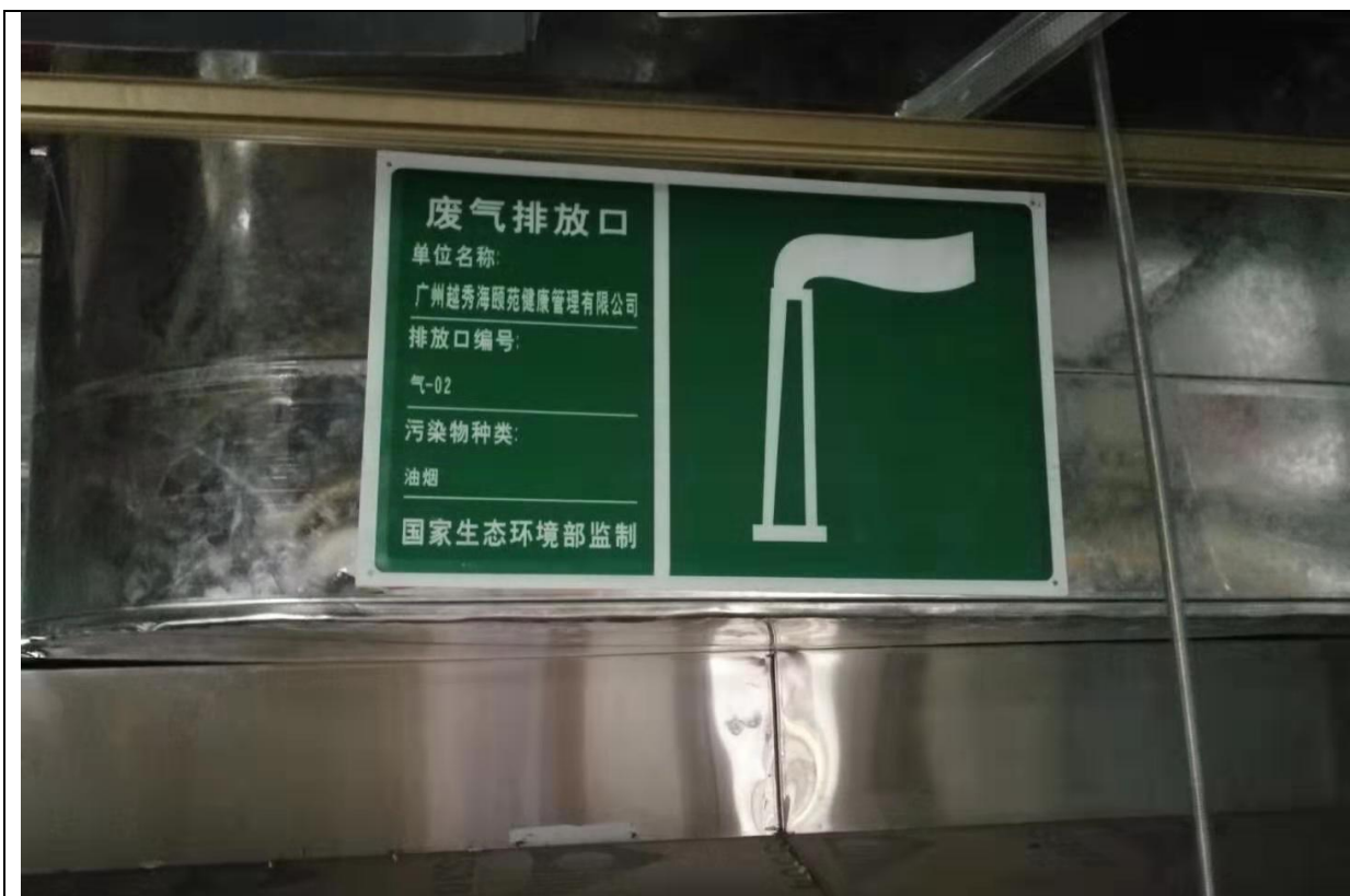
废气排放口：气-02（近照）
