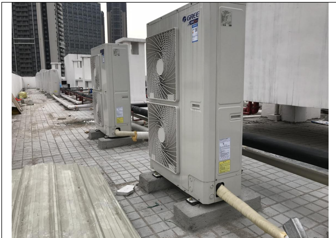
多联机空调系统减振
