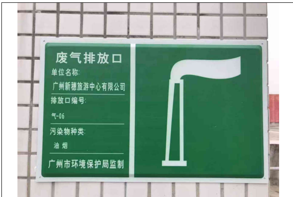
油烟废气排放口：气-06（近照）
