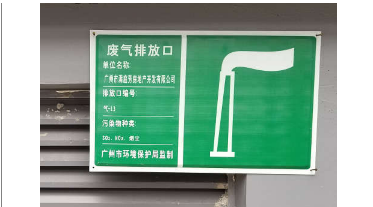
发电机尾气排放口：气-13（近照）
