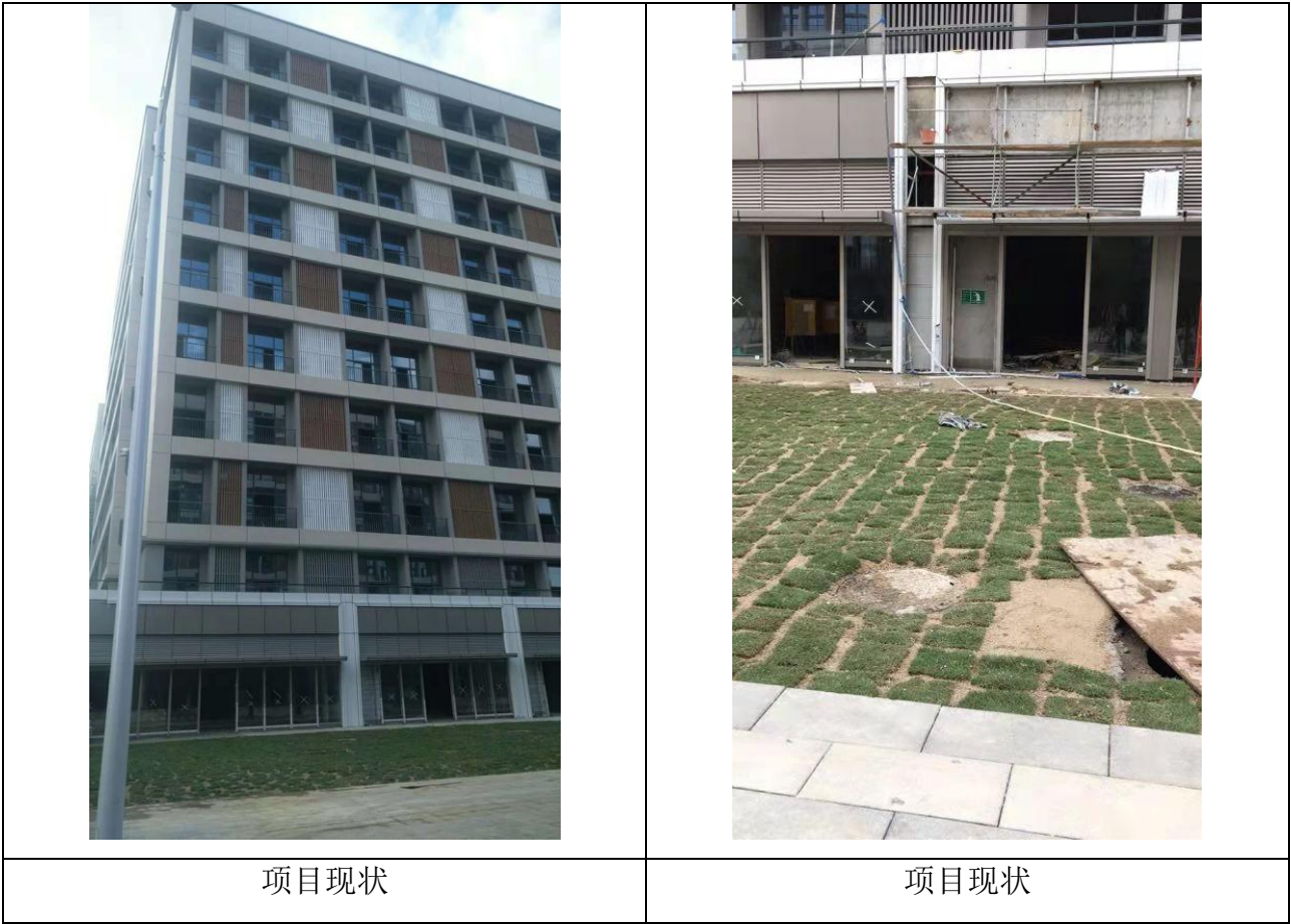
图 3.3-2 建设项目及周边情况照片
