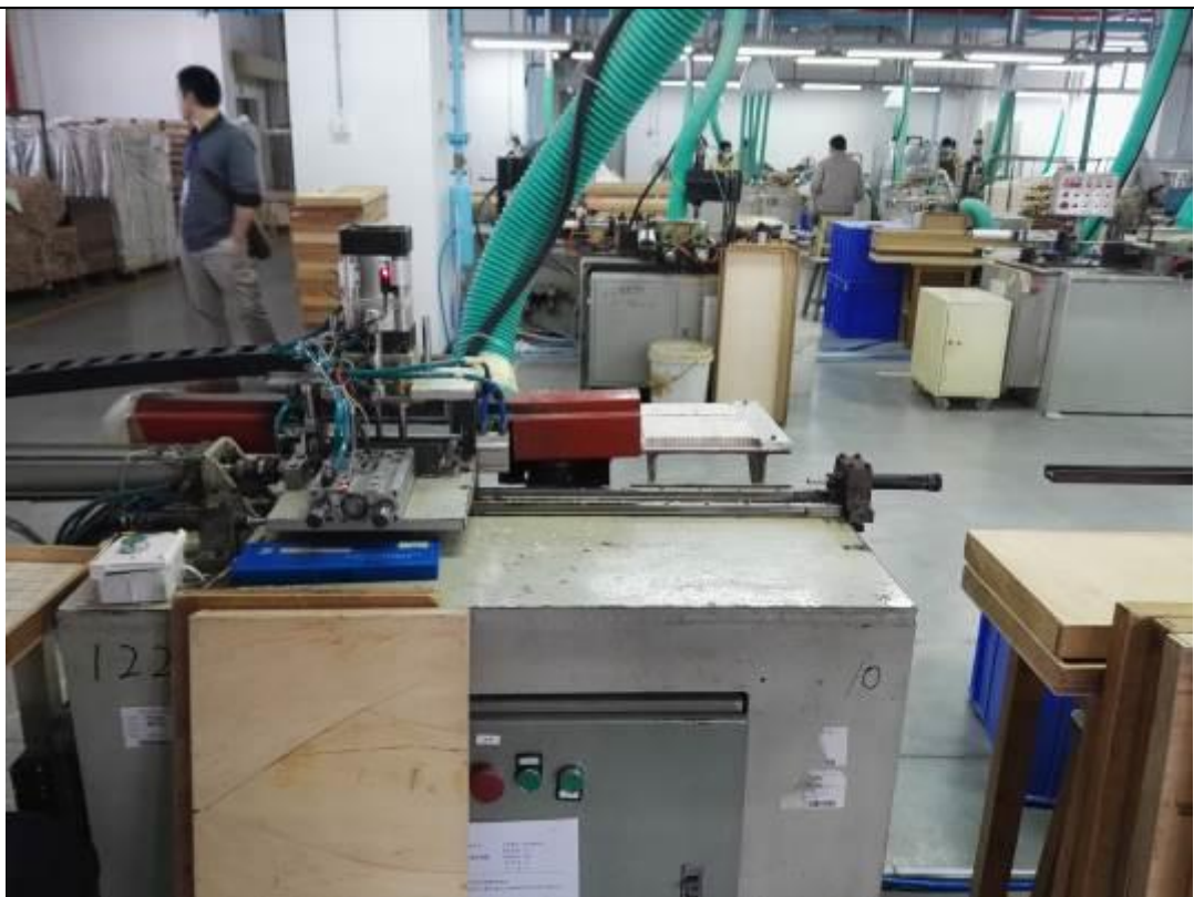
粉尘废气集风管
