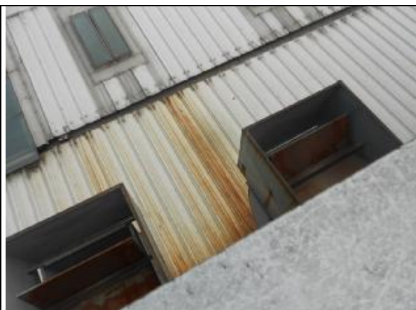
有机废气楼顶排气口
