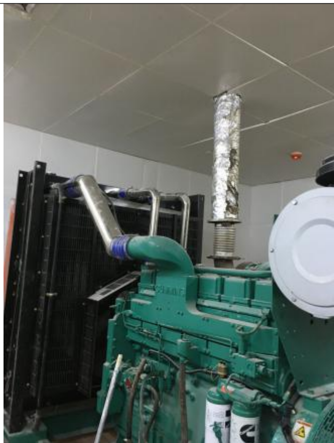
发电机房吸声、排烟管
