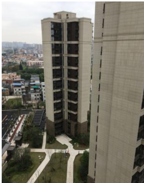
南面荔湾荟 3#住宅楼
