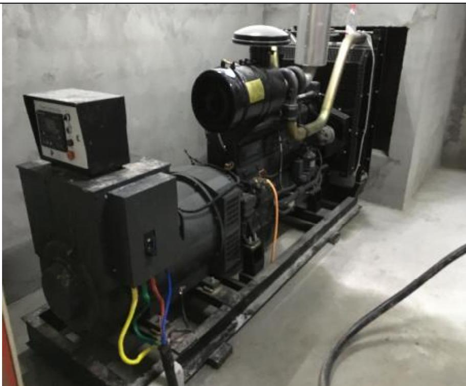
发电机房备用发电机及减振
